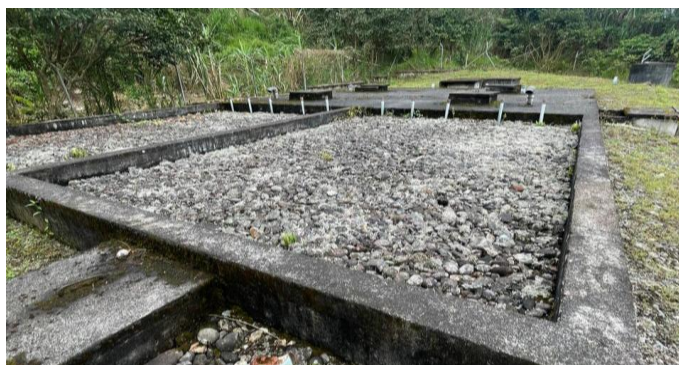
Imagen 27 Planta de tratamiento barrio Brasil de Franco
